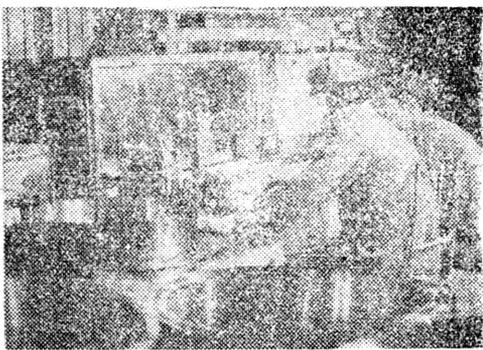
陕西精密合金厂试制成功钢带成品自动检验台，保证了钢带尺寸、表面的质量和人身安全，减轻了工人的劳动强度。
