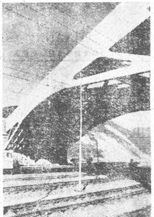
宝成铁路线上的红花铺火车站，每年都受到洪水袭击。84年底，铁一局五处三段职工在这里架起了一座框架结构的泥石流渡槽，从而使该站的安全得到了保障。寒街摄
