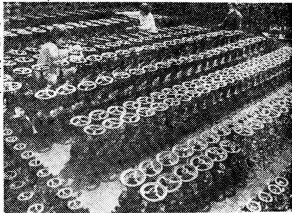
勉县阀门厂生产的旋启式止回阀、暗杆楔式单闸板闸阀，填补了我省低压阀门的一项空白。李仁义
