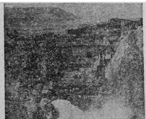
正在建设中的黄河第一坝——龙羊峡水电站，施工条件差，地质构造复杂，被国外专家称为“挑战性工程”。坝高178米，库容量247亿立方米，装机容量128万千瓦，为国内之最。今年内将有两台机组发电，预计1989年工程全部竣工。
