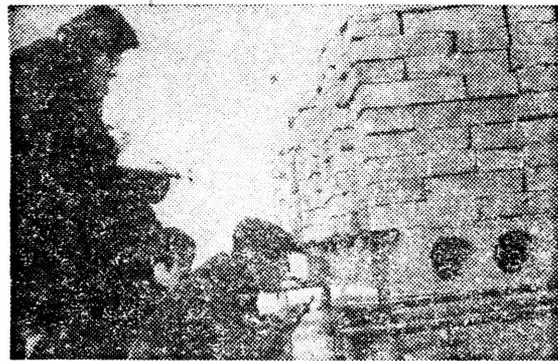
西安市建一公司二工区认真抓工程质量。在施工中，他们对工程所需材料和构件，都要进行认真的检查。图为工程技术人员在对模板进行抽样负荷试验的情景。 卢金贵 摄
