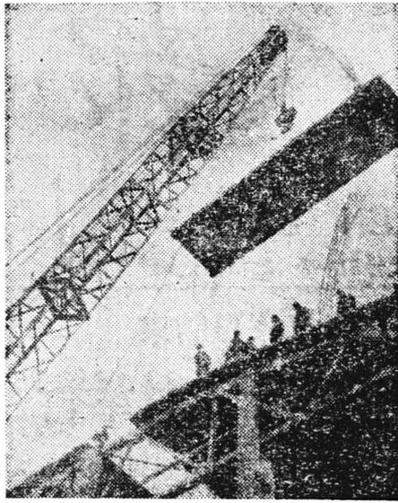
陕西压延设备厂依靠自己的力量对工厂进行搬迁改造，既加快了工程进度，又节约了基建投资。图为金工车间24米宽楼板吊装合拢的情景。
