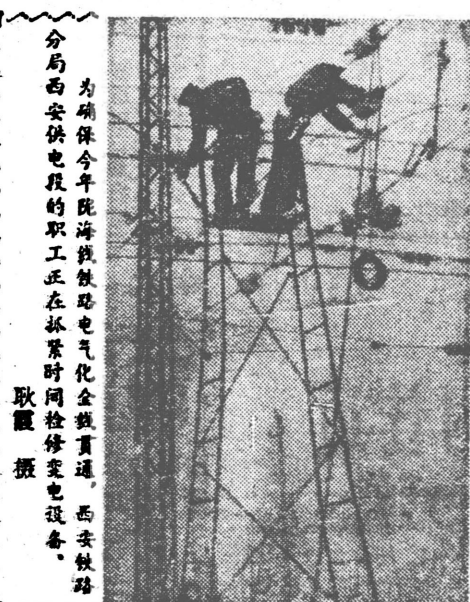
分局西安供电段的职工正在抓紧时间检修变电设备。
