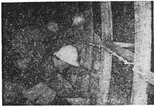
为西安人民关注的黑河引水一期工程正在加紧施工。由铁一局一处承建的长约7公里的少陵原、神禾原隧洞目前已成洞4公里。这是工人在隧洞内立拱架、上模板。 茂周 宋源 摄
