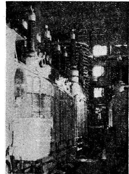
西安变压器电炉厂为我国大秦线电气化铁路提供的六万三千伏安牵引变压器，最近在西安通过国家级技术鉴定。该产品的制造成功，结束了我国电气化铁路牵引变压器只能靠进口的历史。
