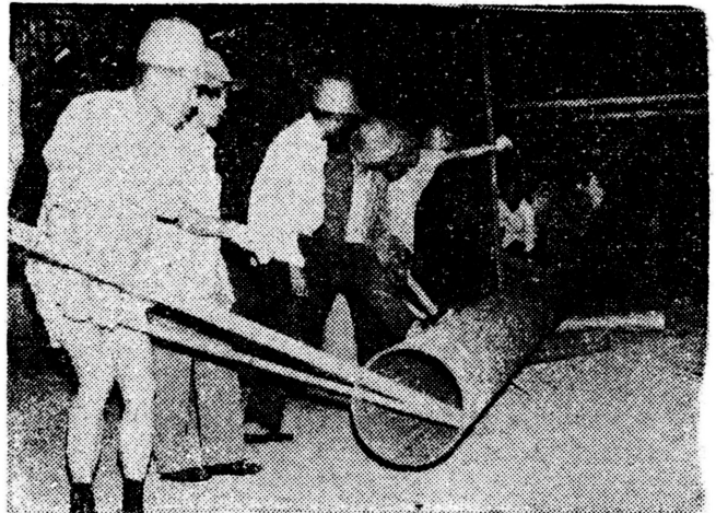
为稳定职工情绪，尽快把被劫乱造成的损失夺回来，省建一公司安泰分公司坚持每周组织机关干部到工地参加劳动，受到工人的欢迎。 肖峰摄
