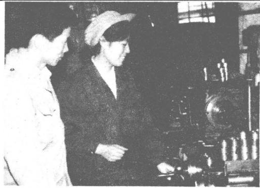
国营昆仑机械厂机加三分厂工程师薛普选(左)，挖掘旧设备潜力，先后改进了四台老机床。内锥螺旋风铣改成后提高工效10倍，半自动圆弧铣改成后受到操作工人的欢迎，使老设备焕发了青春。 雷连生 摄
