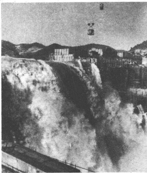
国家重点工程安康水电站，上半年大坝经三次过水，各施工部位照常施工毫无影响。图为过水时形成的瀑布景观。宋晓礼 摄
