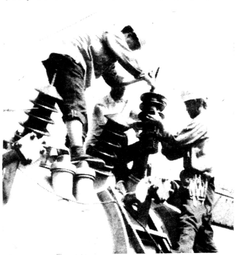
渭南供电局职工正在抢修富平县华阳变电站一台2万千伏安的变压器，以缓解周围四县抗旱缺电的局面。贾书新摄
