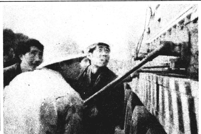
陕西送变电工程公司机运处发挥大型机械运输的优势，去年抢运大型变压器十台，创利八十多万元。这是他们正在抢运庄头一号变压器。 邓允征 摄
