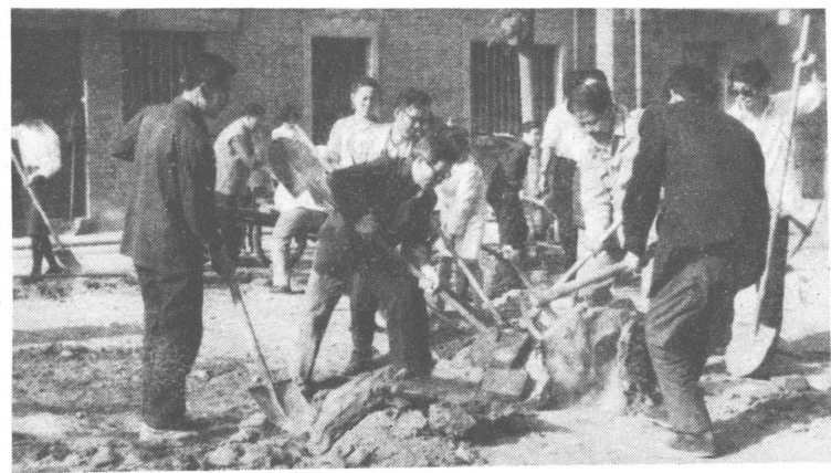
省地质三队工会克服资金紧缺，组织会员开展义务劳动，搬走了堆等困难，对旧锅炉房进行翻修改造，积如山的垃圾，平整了院内百余平方米，建起了职工文化活动中心。图为工
