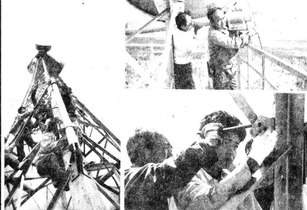
由中国通信建设第二工程局承建的大兴安岭东、西部林区微波接力工程，正在紧张地施工，目前已完成工程总量的70%。 该工程线路全长1900.83公里，东西部共设71个微波站，这条线路建成以后，将在林区形成一个完善的、具有八十年代末先进技术水平的传输网。二局施工人员团结一致，克服了林区气温低、风大、雨多、无路、无水、无电等诸多困难，现在东西部已完成48个站点的安装、调测任务，防火专线正在加紧施工。图为紧张安装中的几个场面。（白建民 张志霞摄影报道）
