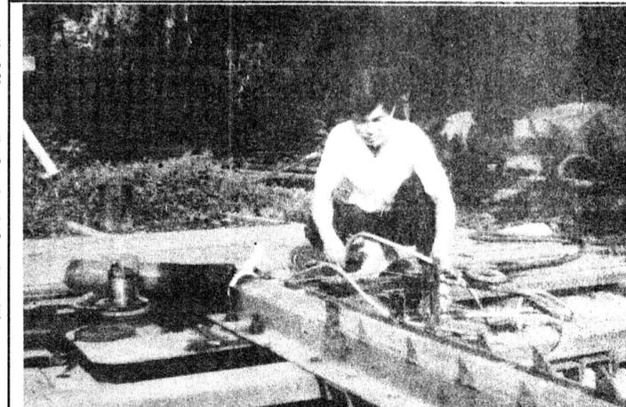
西安铁路工程一公司五队管道工胡国春,为解决施工急需的Dg125毫米管道弯管机,研制出了火焰弯管机,既保证了工程工
