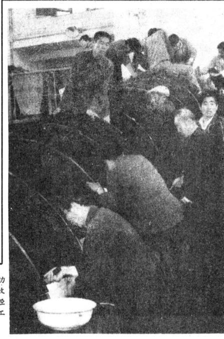
东桐峪金矿坚持开展双增双节活动，在增加经济效益上下功夫。利用选矿厂检修之机，集中回收金和金沙，两天时间，回收粘在螺旋分级机叶片上的金23.35公斤，淘出金沙约18吨，经提炼金加工后，所得黄金总价值约132万元。
