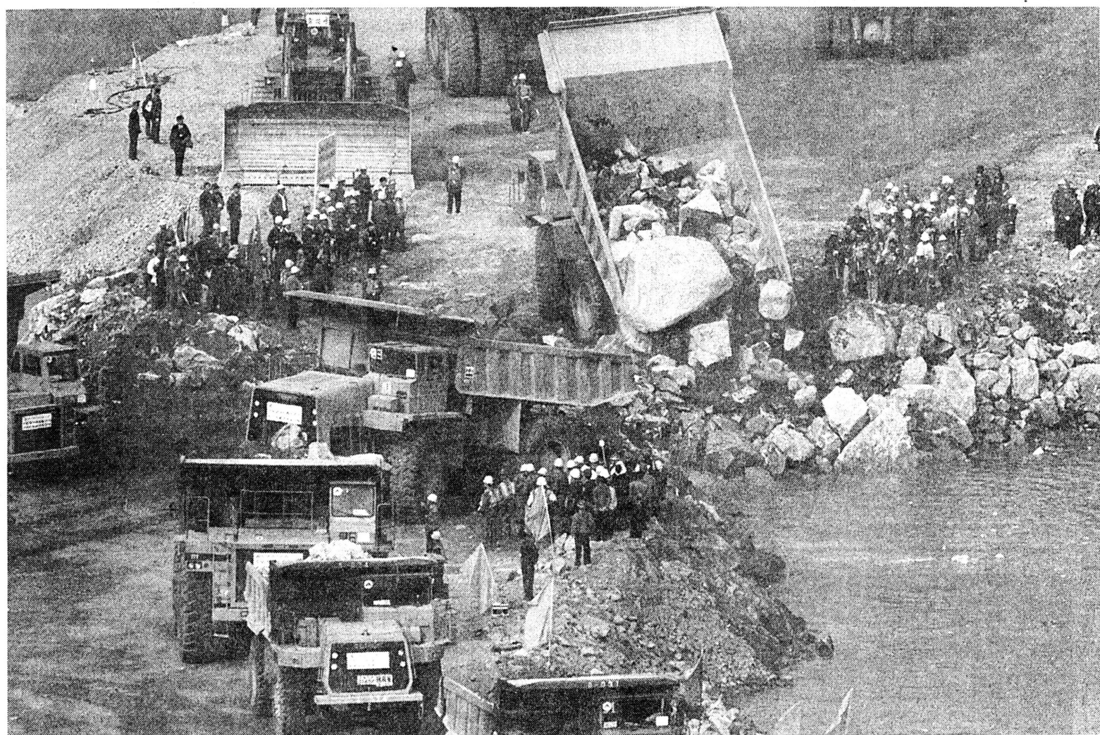
▲大型自卸车抛投合龙前的最后一车石料
