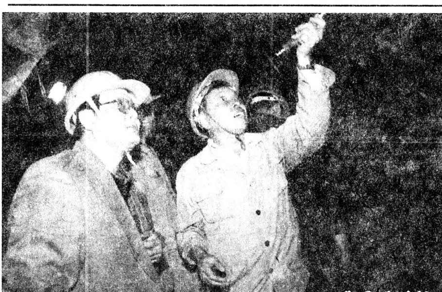
铁一局施工队工人正在施工。
