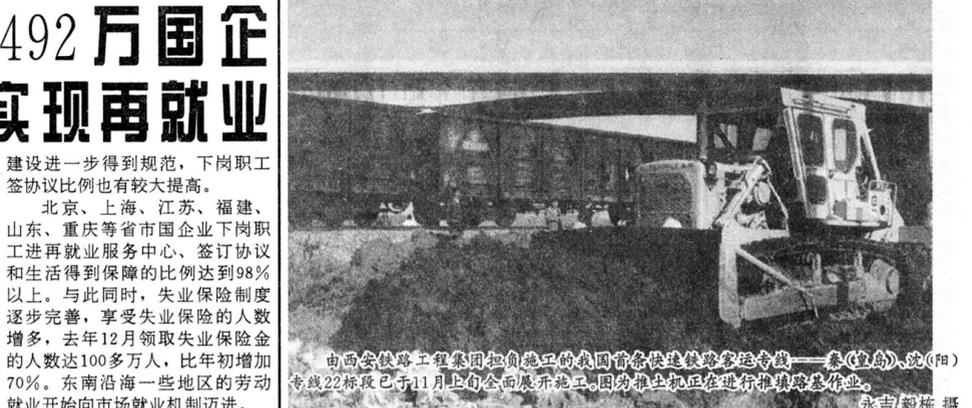
由西安铁路工程集团承担的我国首条快速铁路客运专线——秦(北)京(西)线22标段已于11月上旬全面展开施工。因推出机正在推行路基作业。(张永吉 摄)
