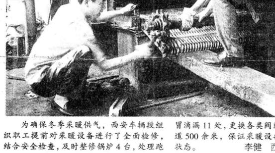
为确保冬季采暖供气，西安车辆段组织职工提前对采暖设备进行了全面检修，结合安全检查，及时整修锅炉4台，处理跑冒滴漏11处，更换各类阀门27个，包扎管道500余米，保证采暖设备始终处于良好状态。
