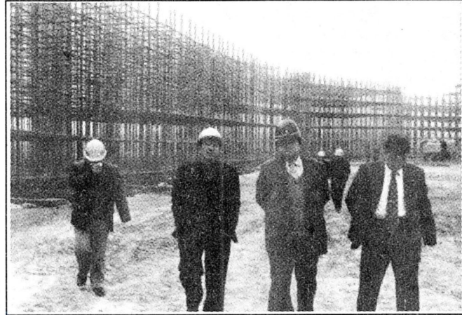
中铁十八局副局长杨玉刚同志(左二)在五处十一公 司总经理鹿清平(右二)、项目总工程师李新顺(右一)陪同 下视察帽耳立交桥梁工地
