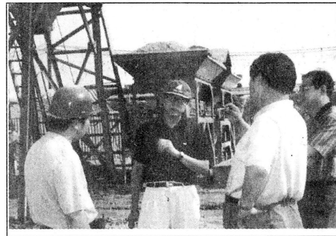
中铁十八局李洪奇副局长(左二)视察五处帽耳立交桥梁
