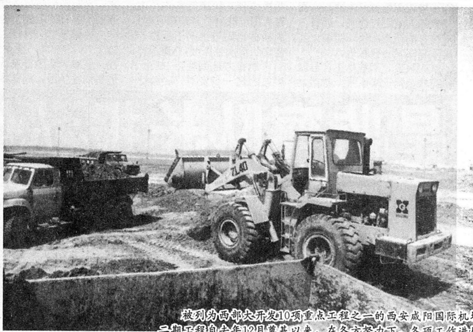
被列入西部大开发10项重点工程之一的西安咸阳国际机场二期工程自去年12月奠基以来，在各方努力下，各项工作进展顺利。目前，新候机楼土方工程已接近尾声，地基强夯工作即将开始，污水处理等配套设施也在加紧进行。
