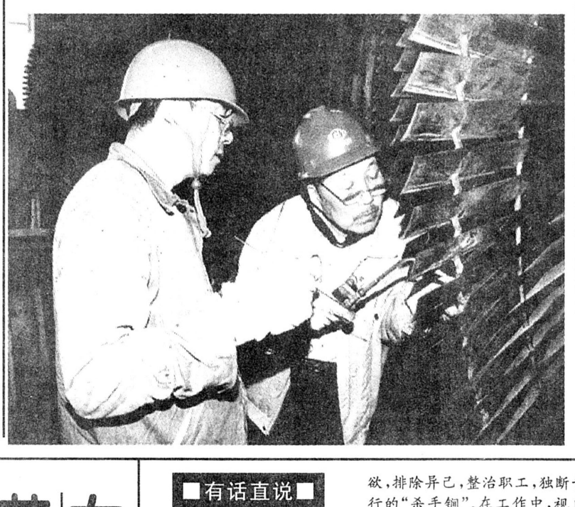
蒲城发电有限责任公司在1#机组首次大修中狠抓工艺检修,为创一流企业奠定基础。图为检修人员在精心补焊汽轮机叶片拉筋。 张恒学 摄
