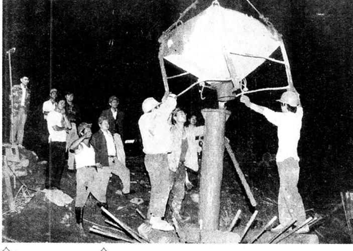
省重点工程210国道(波)线(区)路面向社会招标后，各施工单位于5月上旬进场，历经6至7次水毁后，各标段经理部积极开展劳动竞赛，抓质量、赶进度，夜以继日。已累计完成土石方26万方，坚石硬土26.2万方，涵洞20道，为超额完成本年度任务打下了基础。图为深夜桥梁灌桩施工现场。张纪平 摄
