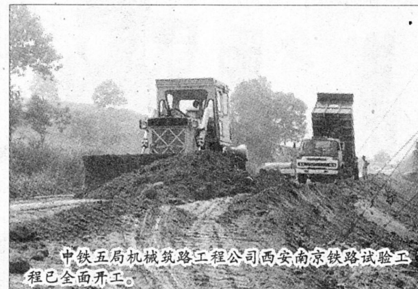
中铁五局机械筑路工程公司西安南京铁路试验工程已全面开工。
