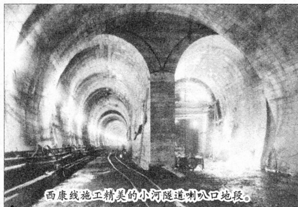
西康线施工精美的小河隧道喇叭口地段。
