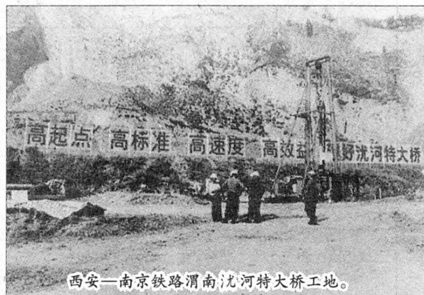
西安—南京铁路渭南流河特大桥工地。
