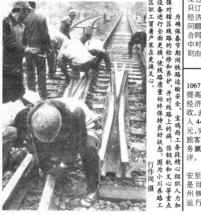
为确保持续春节期间铁路运输安全，宝鸡西工务段精心组织人力，对辖区线路的检修和养护，并对线路上的病伤钢轨和叉心等重点设备进行全面的更换。图为小川铁路工区工务段正在更换叉心。
