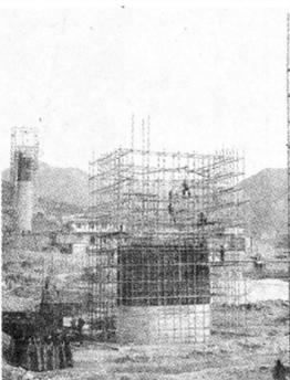
西南铁路重点工程——全长520米的南坪武家河特大桥,最高墩身46米,采用沉井、挖井、明挖三种工艺进行桥墩基础施工...
