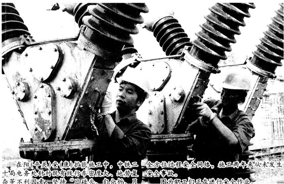
在阳(平)安(康)扩能施工中,中铁三局全方位推进安全网络,施工两年来从未发生十局电务处针对既有线路车密度大、地势复杂、安全风险高等不利因素,坚持“四不放过”原则,严把安全关,确保施工安全。图为职工们正在进行安全作业。
