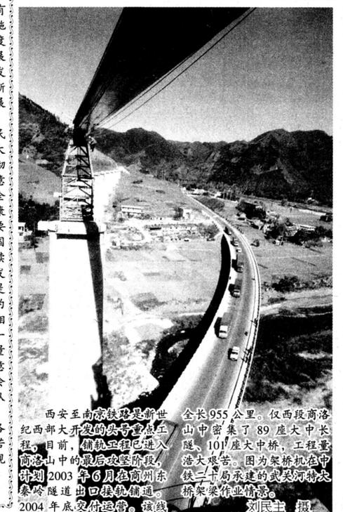
西安至南京铁路是新世纪西部大开发的头号重点工程,全长955公里。仅西段后洛山中密集了89座大中桥梁、101座大中桥,工程量大。图为架桥机在秦岭隧道出口段架桥。计划2003年6月在商洛东秦岭隧道出口段架桥。架桥机作业价值高。2004年底交付运营。刘民主 摄
