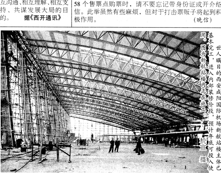
基本完工的西安咸阳国际机场新航站楼,预计年底可投入使用。
