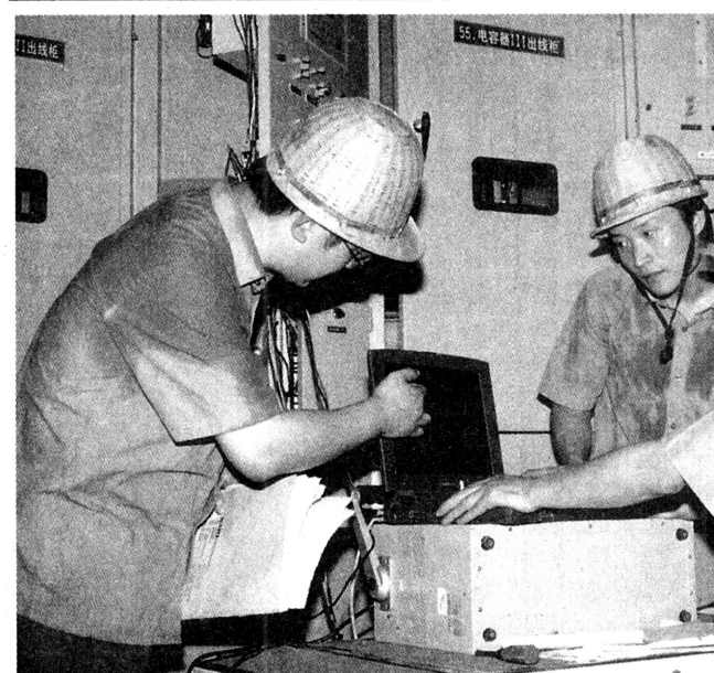
七月流火,酷热难耐。渭南供电局在龙钢输变电工地(用户工程)会战的百余名职工冒高温、战酷暑,顽强拼搏,艰苦奋战,使工程的安全工期质量得到可靠保证,力争给用户交一个满意工程。图为职工在汗流浹背调试设备的情形。
