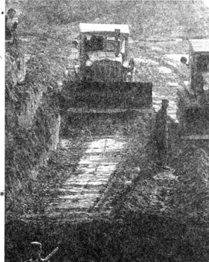
某部“老虎团”官兵齐心协力架舟桥(9月10日下午5时,石堤河上架起一座长61米、宽10米、可承载20吨的浮桥)。
