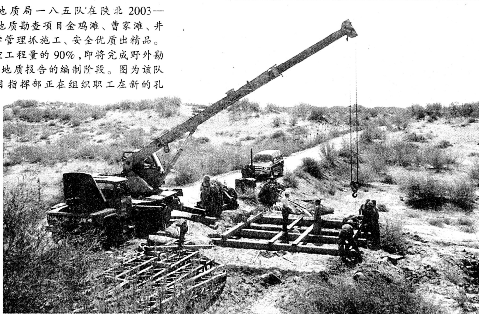
省煤田地质局一八五队在陕北2003—2004年重点地质勘查项目金鸡滩、曹家滩、井田施工中科学管理抓施工、安全优质出精品。现已完成钻控工程量的90%,即将完成野外勘探施工,进入地质报告的编制阶段。图为该队重点勘查项目指挥部正在组织职工在新的孔位上安装钻探设备。
