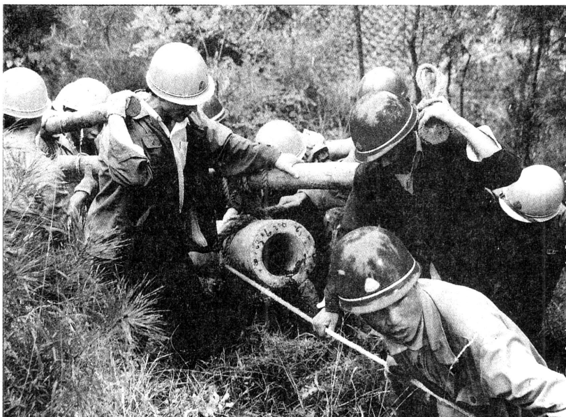
特大洪灾使洛供电局电力设施遭到严重破坏,该局迅速组织抢险救灾工作,成立了10个抢险组,80个抢险队,奋战在抗洪救灾第一线。大部分电力线路已恢复供电。图为抢险救灾突击队抬杆架设线路。
