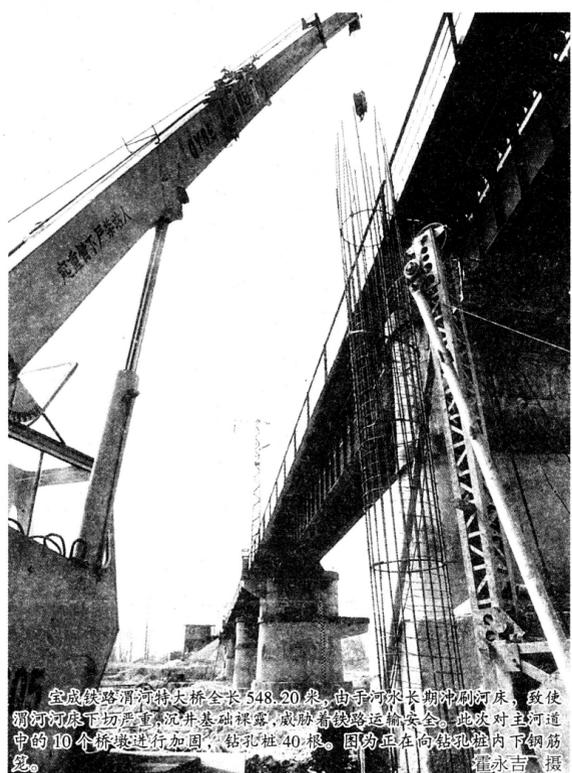
宝成铁路渭河特大桥全长548.20米,由于河床长期冲刷河床,致使河床下陷,危及桥基安全,威胁着铁路运输安全。此次对渭河中的10个桥墩进行加固,钻孔桩40根。图为正在向钻孔桩内下钢筋笼。
