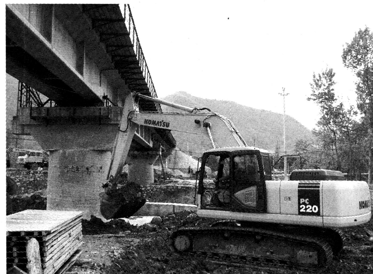
西铁工程一公司正在对西康线大峪口铁路桥墩基础进行加固处理,2005年秋季暴雨对桥基造
