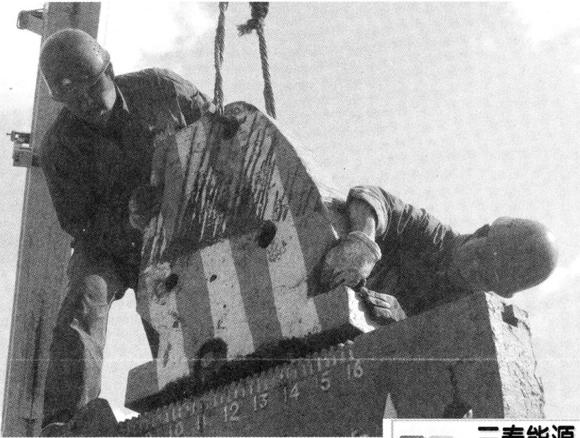
近日,在长采三厂五里湾一区一井站,副队长菊小亮和维修大班职工张顺平顶着烈日,在3米高的抽油机底座上安装平衡块。安装抽油机需吊车配合,七八个人忙活一天后,新油井便可流出黑色的石油。 本报记者 薛生贵 摄
