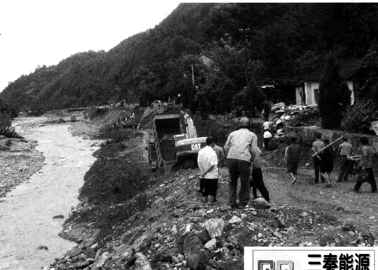
近日, 我省公路职工日夜抢修水毁公路, 全力保障恢复交通, 图为正在 312 国道丹凤县铁峪铺水毁路段抢修便道, 据最新消息, 目前 312 国道已经恢复通车。 周鹏华 摄
