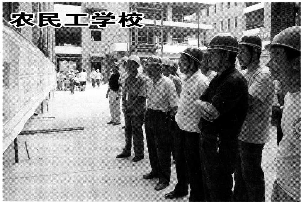
华山建设公司因地制宜,在施工现场开办农民工学校,对农民工进行施工技能和安全生产培训,提高农民工技能,使安全工作落在实处。图为该公司第五项目部农民工学校在五洲风情工地组织农民工接受现场施工安全案例教育。高祖衡 摄
