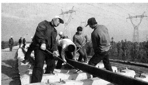
担负呼和浩特中燃公司铁路专用线铺轨施工任务的中铁一局新运托电运输公司员工冒着内蒙古高原上的寒风,不怕苦、不怕累,掀起“大于120天、确保年度计划完成”劳动竞赛。
