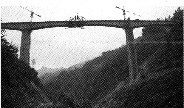
日前,襄渝铁路复线位居亚洲第二的朱溪河右线大桥主体工程合龙。它和新毛坝关隧道、朱溪隧道贯通连接,至此襄渝铁路复线中段的7.373公里咽喉工程已完成,为襄渝铁路复线早日完工交付使用创造了有利条件。图为已合龙的亚洲第二大桥——朱溪河右线大桥。
