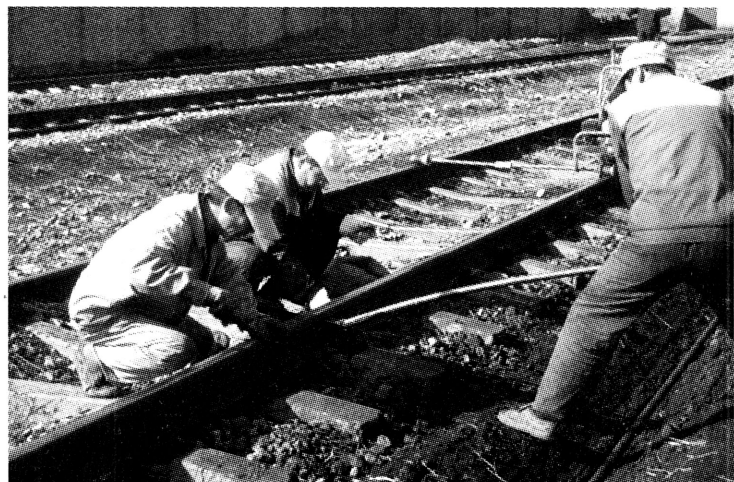
在“百日安全”活动中,陕煤化集团澄合铁运处积极整治线路隐患,针对王村车站三道装车线承载负荷大,轨枕橡胶垫易磨损实际情况,积极更换,确保了线路畅通无阻。刘洪摄
