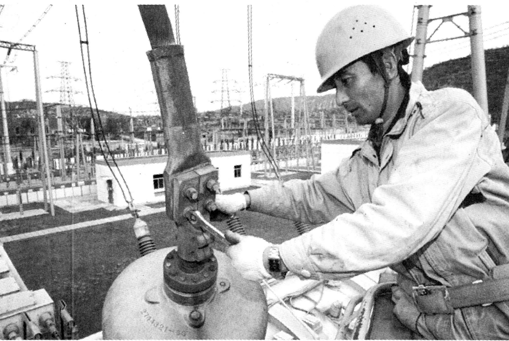
连日来，延安供电公司全面开展秋检工作，抽调精兵强将对延安、黄陵、朱家沟三座330KV变电站进行全面的检修和消缺，为迎峰过冬，安全供电做好了准备。图为11月5日，该公司职工对330KV黄陵变电站进行综合检修。
