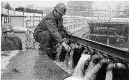
地铁施工中常会有大量的地下水要排放,如何把施工过程中产生的地下水排出作业区,一直是一件令建设者们头疼的事情。如今,在中铁电化局西铁工程公司西安地铁北大街施工现场,由于实施了一项小
