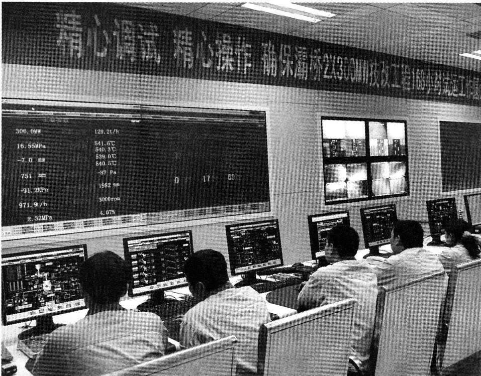
精心调试 精心操作 确保灞桥2x300MW技改工程168小时试运行
