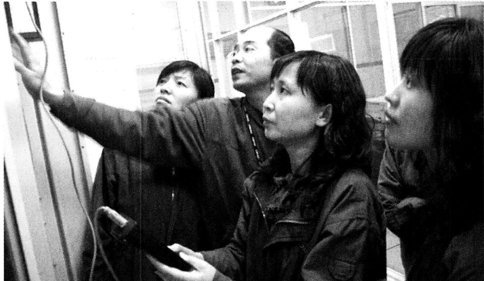
咸阳机场能源动力公司供电站高压二班术难题时总是集思广益。图为组员相互交流电力设备运转情况。 本报记者 柳江河 摄
