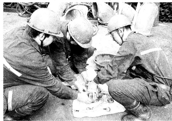
象山矿井抽放队积极创建瓦斯抽放精品工程,有效提高了瓦斯抽放效果,为矿井安全生产提供了有力保障。图为职工维修抽放泵配件多路换向阀。田有志摄
