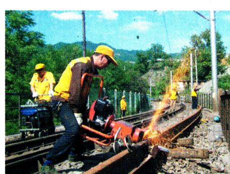
汉中工务段严格规范安全生产责任制,对管内重点施工关键岗位、关键环节进行严格卡控,确保施工安全和质量。图为近日,该段职工在宝成线进行铝热焊后钢轨打磨作业。王春嵘 摄
