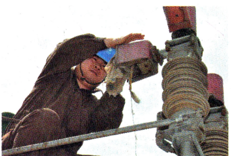
近期,宝鸡供电局按照检修计划,对变电站、输电线路设备进行检修预试。图为近日,该局变电站等单位140余名干部职工对330千伏雍城变电站1、2号主变一、二次设备进行综合检修。 李玉朋摄
